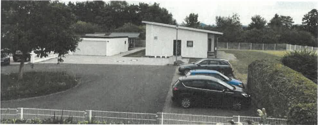
Ansicht von Westen mit Wendepplatz und öffentlichen Stellplätzen im Vordergrund
